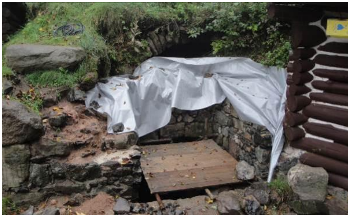
(Vstup do sklepení během rekonstrukce - celkový pohled)
