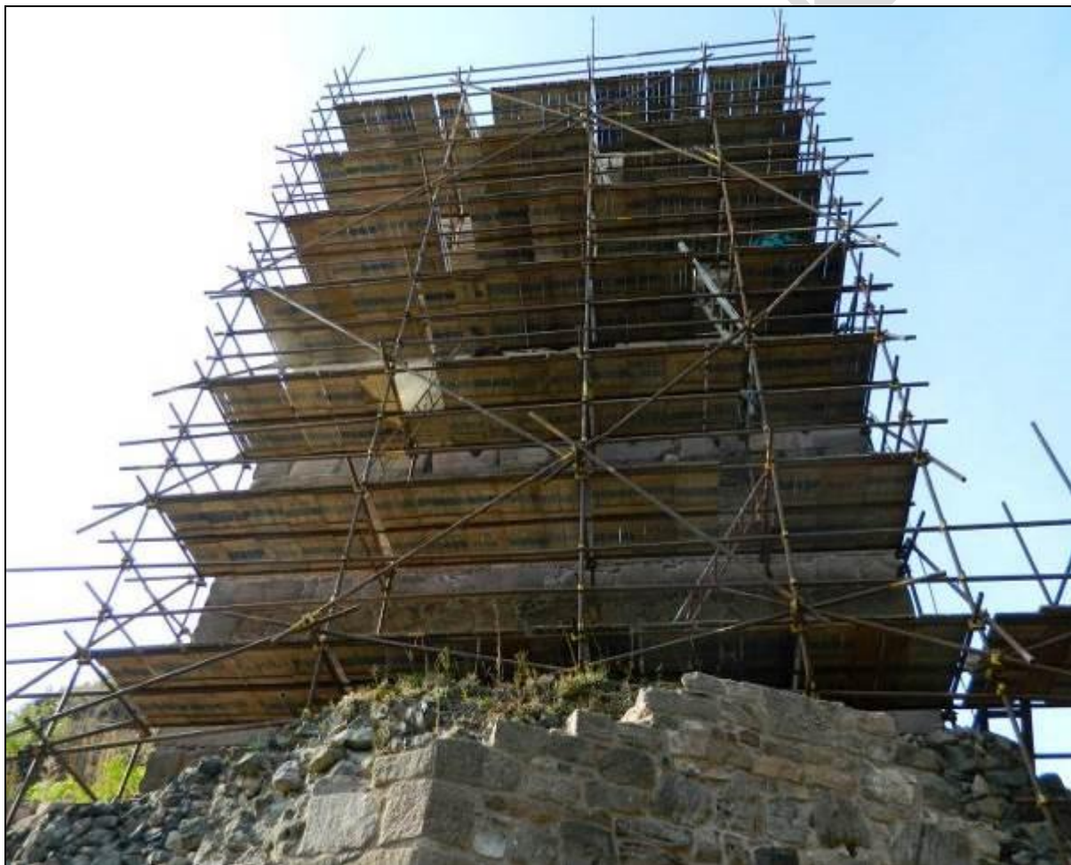
(Hrad Kumburk - staletá dominanta kraje je opětovně částečně zakryta za odvážným lešením)
