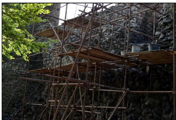
Obr. 5 pohled na část lešení a manipulační plošinu.
