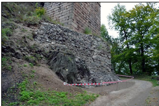
Obr. 4 stav po opravě prvního úseku pod „Velkou“ věží
