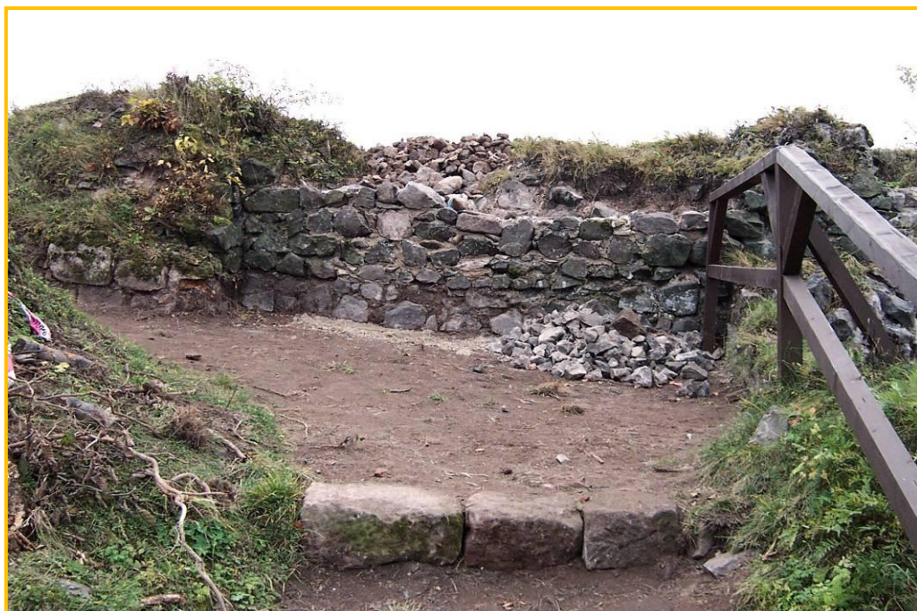
Obr. 8. Pohled na opravený líc zdi naproti schodišti.
