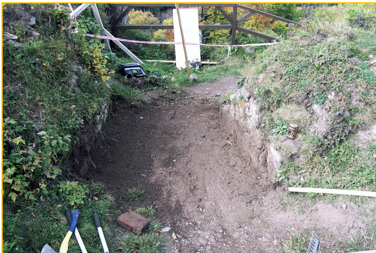
Obr. 2. Pohled na vstup do horního hradu v průběhu prací po vyčištění průchodu, foceno z vnitřní strany.
