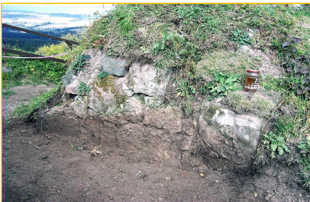
Obr. 4. Detail levého ostění vstupu do horního hradu po vyčištění. Vpravo je patrný větší pískovcový kvádr nároží, obdobný kvádr byl nalezen v suťovém kuželu pod vstupem. Na nalezeném kvádru jsou patrné drážky po broušení nástrojů, zřejmě hrotů šipek. Vlevo je patrný ozub po vylomení portálu dveří. Zbytek zdiva má smíšený charakter z pískovce, čediče a cihel.
