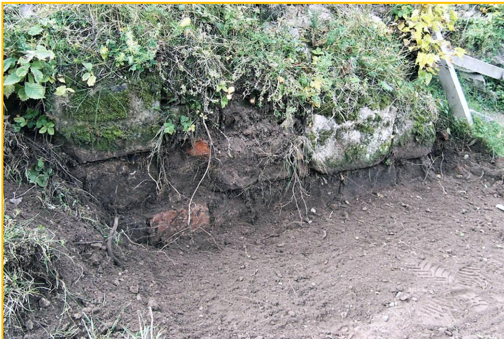
Obr. 3. Detail pravého ostění vstupu do horního hradu po vyčištění. Na obrázku je vidět zbytek cihelné plenty z pozdější doby. Vpravo je patrný ozub po vylomení portálu dveří.
