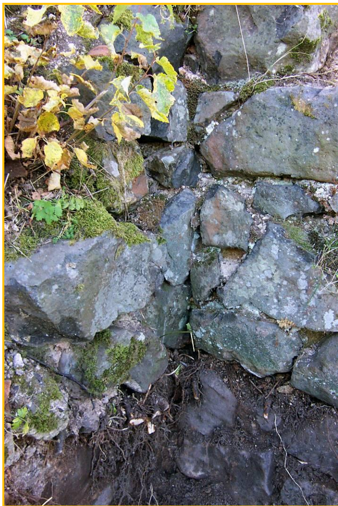
Obr. 5. Detail koutu vpravo od vstupu do horního hradu. Svislá spára napovídá pozdějšímu přizdění zdi, naproti schodišti, vedoucí k západnímu pilíři.
