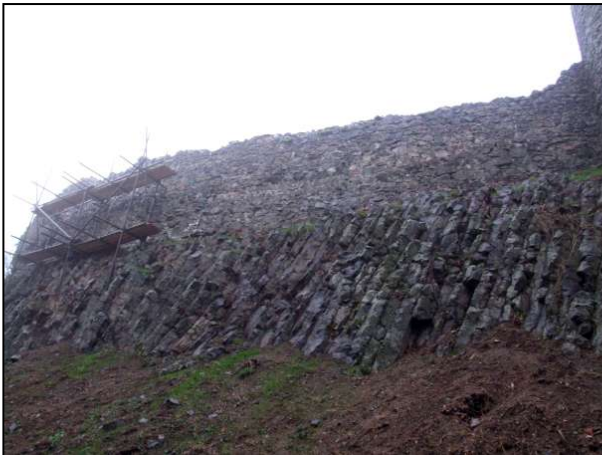
Pohled na dokončenou I. etapu oprav okružní hradby.
