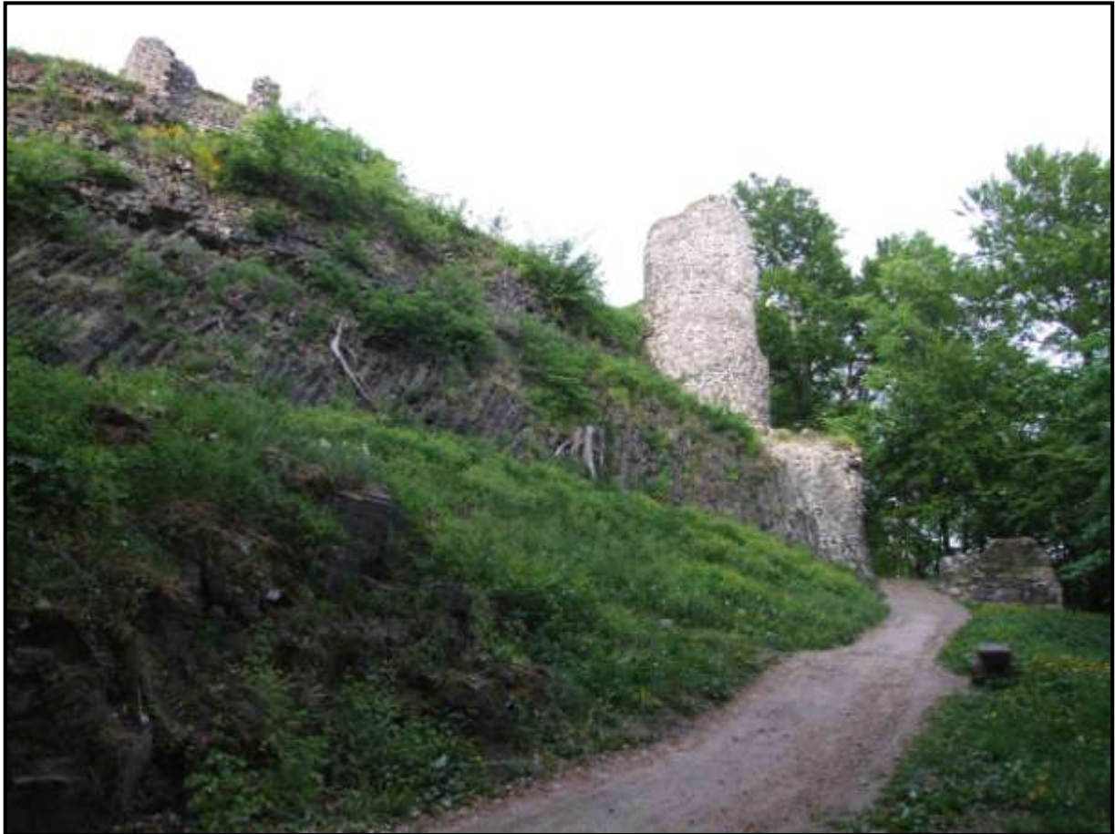
Opravovaná část „okružní“ hradby. Stav před zahájením prací 2008.
