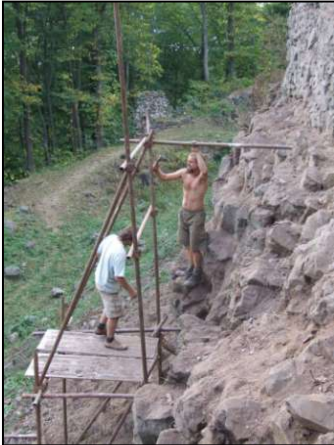
Demontáž pomocného lešení části oprav I. etapy statického zajištění okružní hradby.
