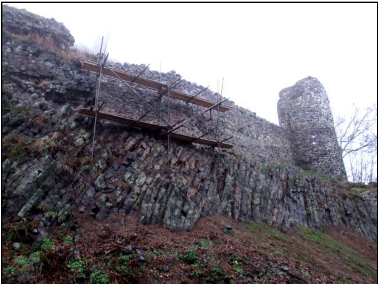
Pohled na dokončení I. etapy opravy okružní hradby. Tato konstrukce prozatím ponechána, v případě poskytnutí dotace 2009 na II. etapu oprav bude využita k přesunu hmot. Část opravené koruny hradby v místě
