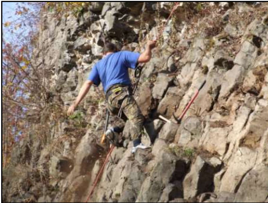
Odstraňování náletových dřevin a nepevných částí skalního podloží.
