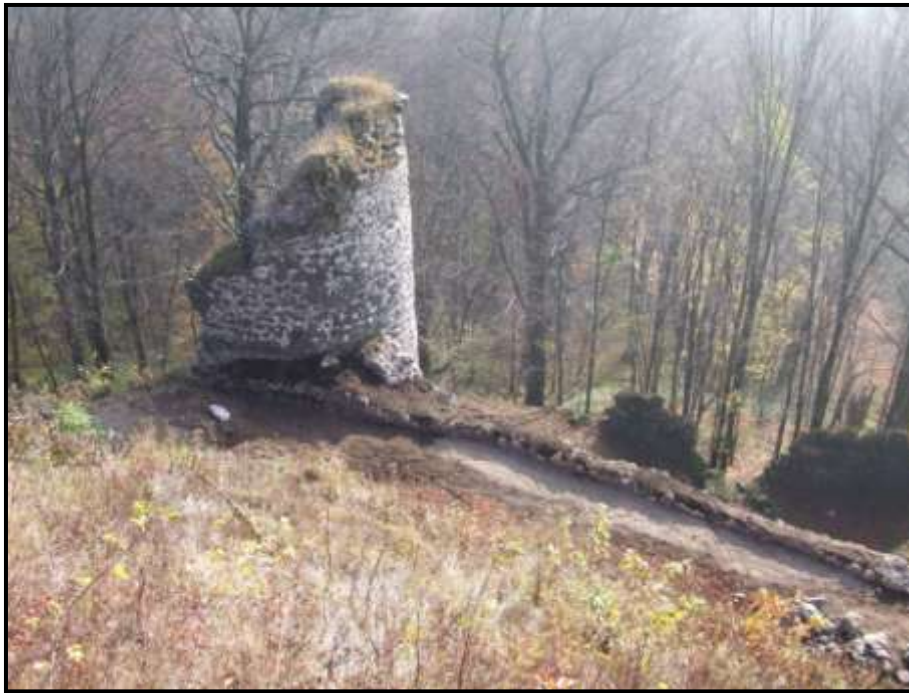
Pohled z hora na opravovanou část I. etapy statického zajištění okružní hradby.
