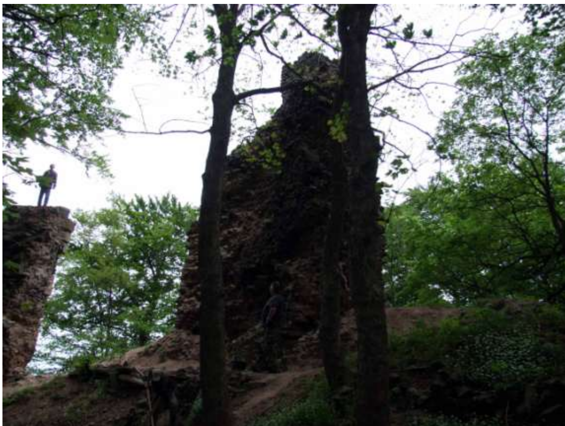
Vnitřní líc dochované části plášťové hradby. (2007)
