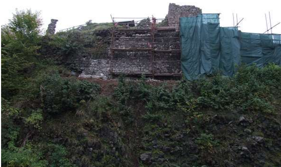
Průběh oprav III. etapy statického zajištění okružní hradby 2010.
