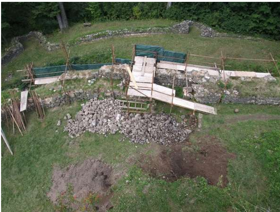
Pohled na opravovanou část shora.
