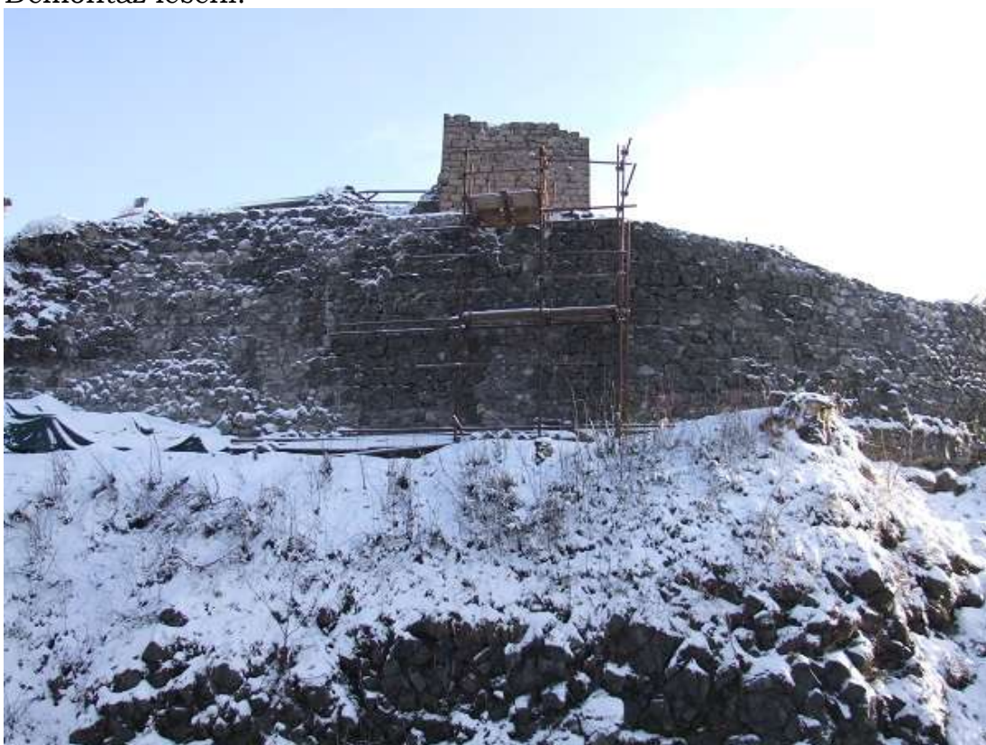
Dokončení oprav III. etapy. Ponechaná část konstrukce lešení usnadní přístup při opravách v příštím roce.
