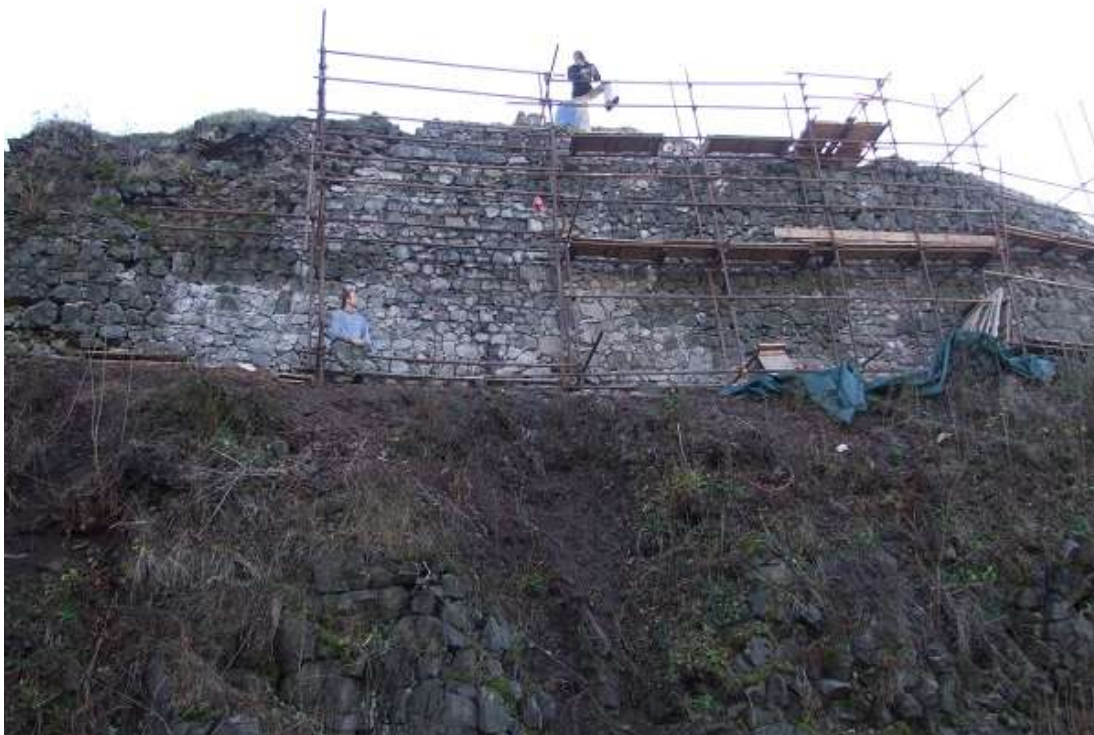
Demontáž lešení.
