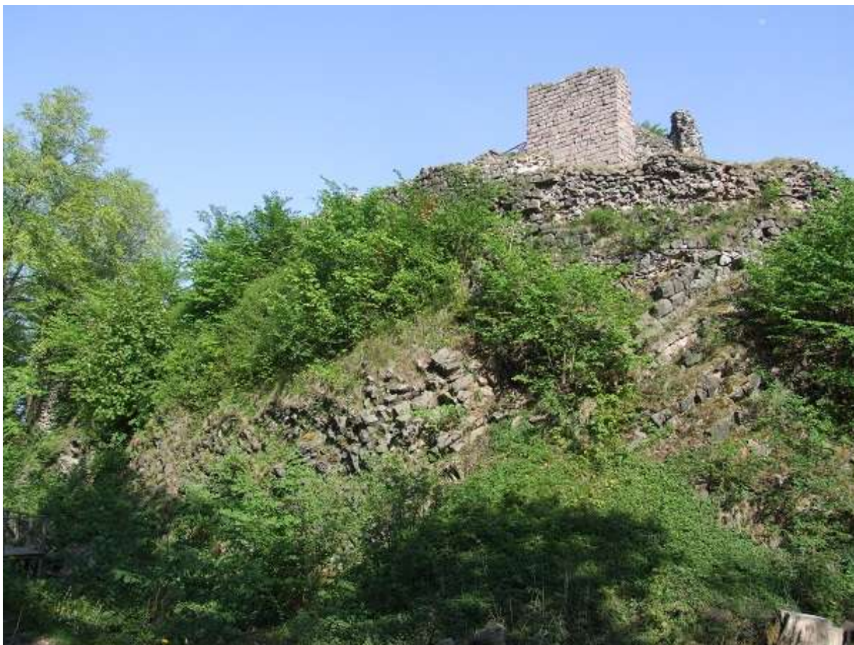
Opravovaná část „okružní“ hradby. Stav před zahájením prací 2009.
