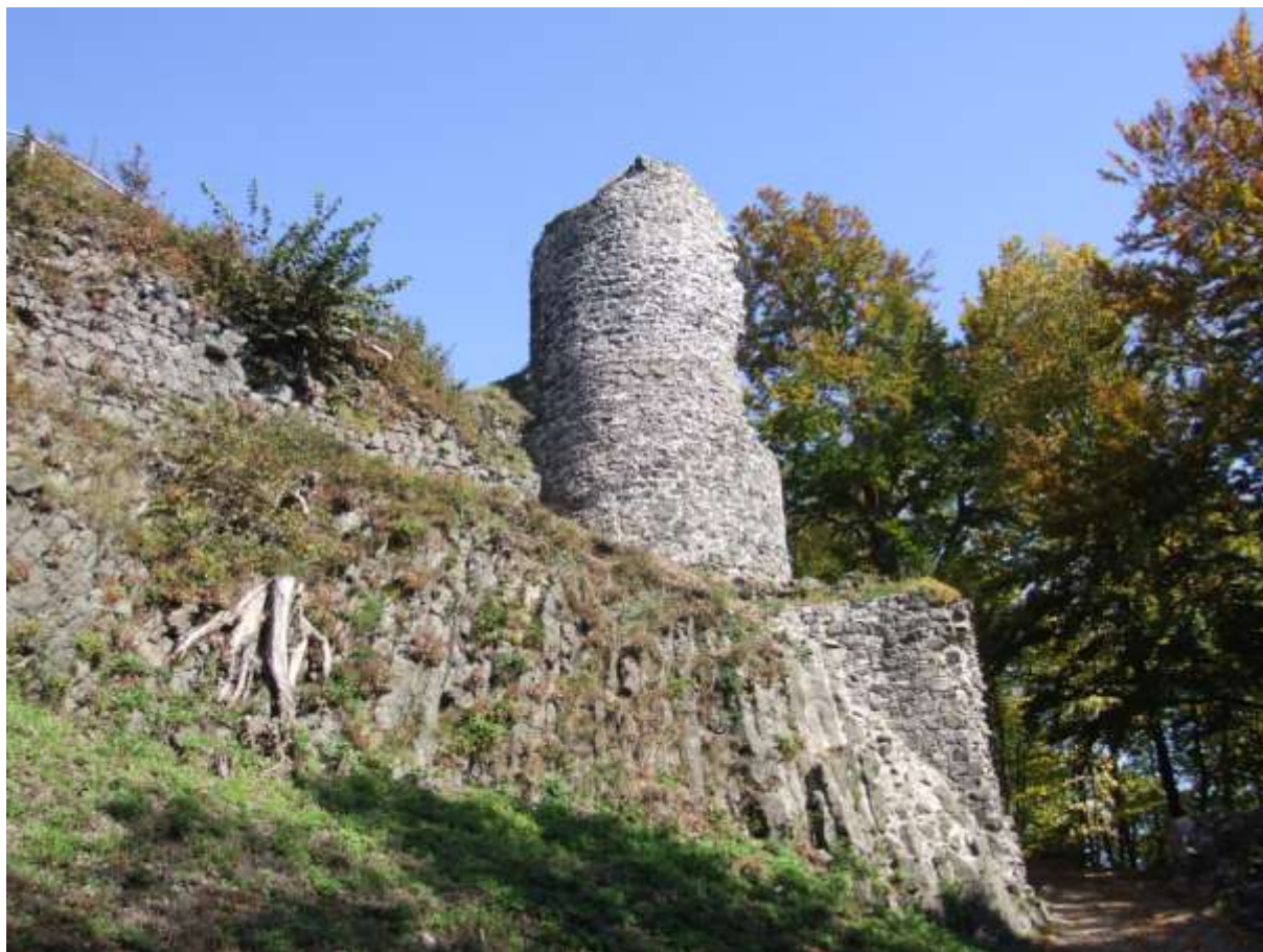
Pohled na opravenou „Panenskou“ věž od první brány.
