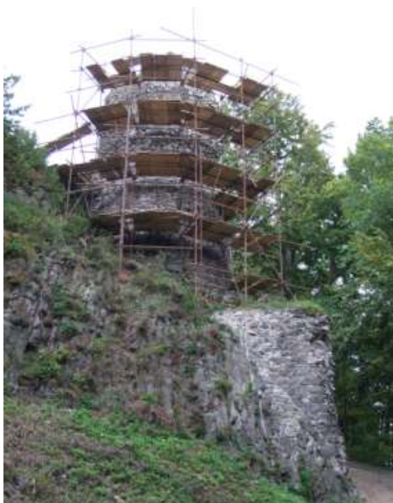
Celkový pohled na opravované části věže. Velmi náročný terén pro montáž lešení si vyžádal kontrolu statika.
