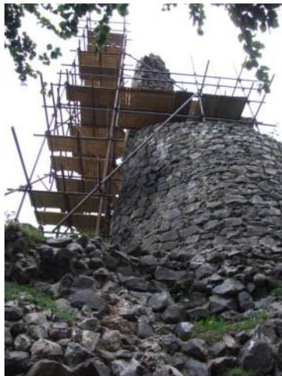
Celkový pohled na opravované části věže. Velmi náročný terén pro montáž lešení si vyžádal kontrolu statika.
